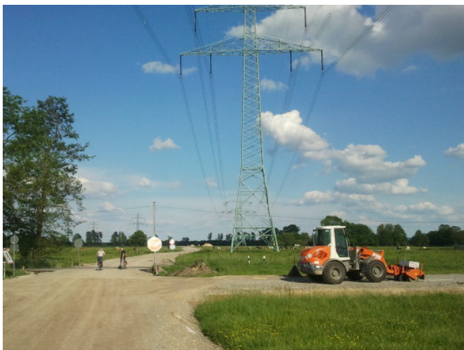
A26-Baustelle (bei Rübke),
